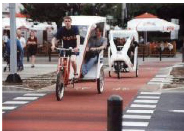
Ryc. 7.3 Przejazd dla rowerów z kolorowego asfaltu Źródło: http://koninnaszemiasto.blox.pl
