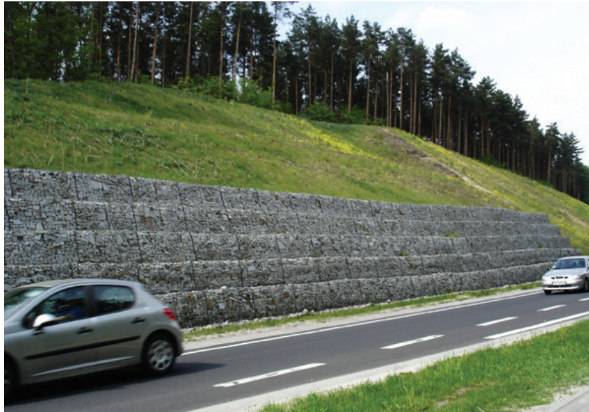
Ryc. 7.13 Przykład zastosowania gabionów na zabezpieczenie skarpy
