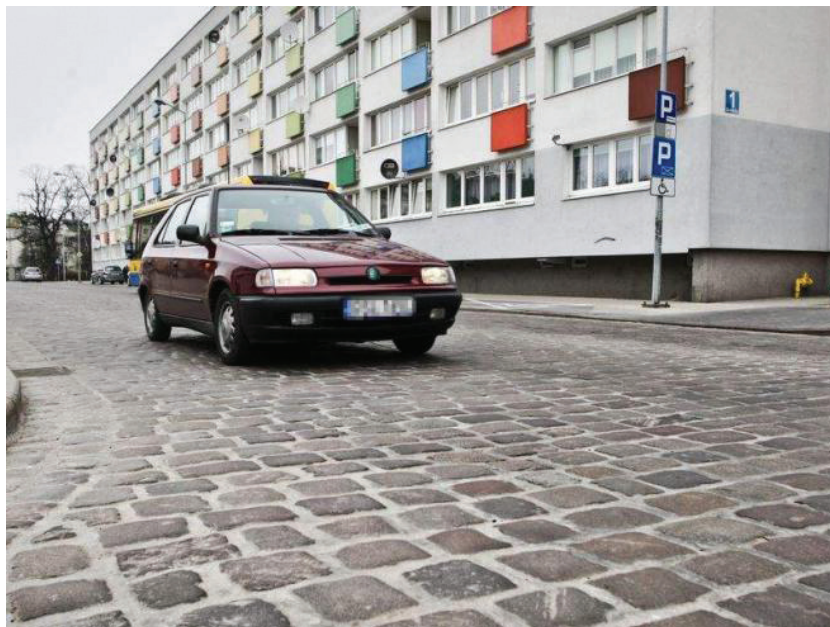
Ryc. 7.4 Nawierzchnia jezdni z kostki naturalnej
