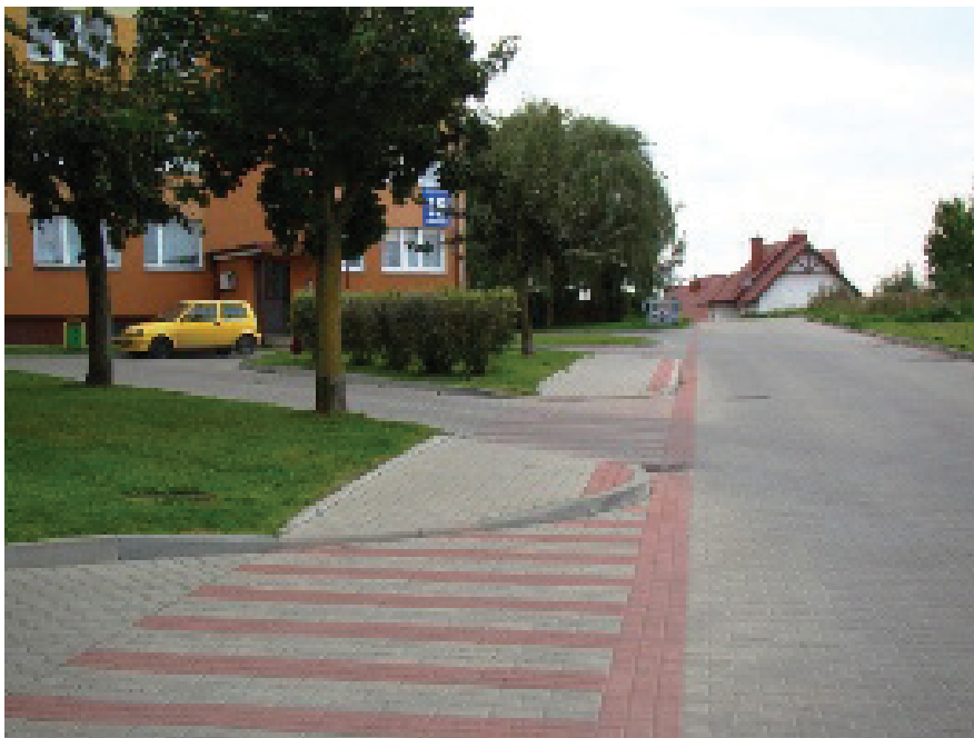
Ryc. 7.9 Przykład przejścia dla pieszych wyodrębnionego za pomocą betonowej kostki brukowej
