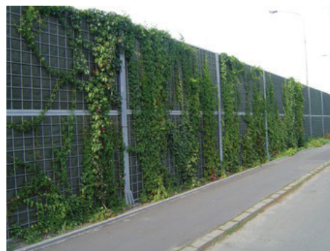
Ryc. 1.1 Ekran akustyczny typu „zielona ściana” Źródło: http://siskom.waw.pl
