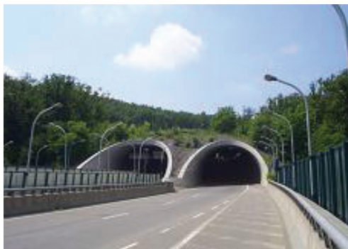
Ryc. 1.5 Przykład tunelu Źródło: http://siskom.waw.pl
