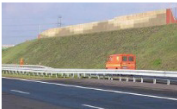
Ryc. 1.6 Przykład przekopu z ekranem akustycznym Źródło: http://siskom.waw.pl
