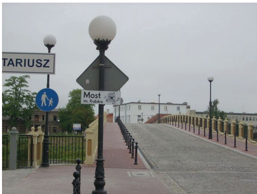
Ryc. 7.6 Nawierzchnia na obiekcie inżynierskim z zastosowaniem kostki naturalnej na jezdni oraz betonowej na chodnikach Źródło: http://www.konin.lm.pl
