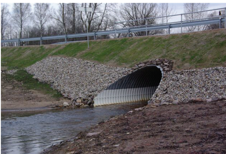
Ryc. 9.12 Przykład wykończenia i umocnienia wlotu przepustu
